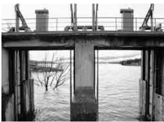
L'ACQUEDOTTO DEL FANACO
