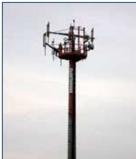
Ancora antenne da installare. Quattro anni fa le stesse persone che oggi amministrano erano contrarie alla installazione. Come mai oggi hanno cambiato idea? Dove è finito l'agguerrito comitato cittadino?
