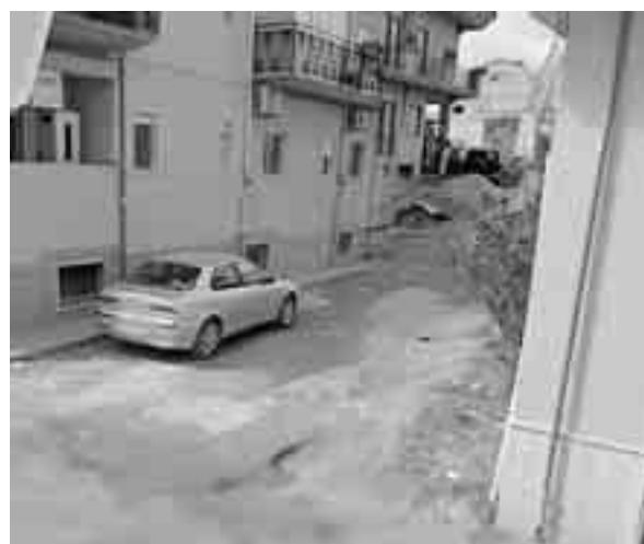
Ancor oggi molte strade del centro urbano sono ridotte a delle trazzere soprattutto a causa di lavori che poi non vengono completati
